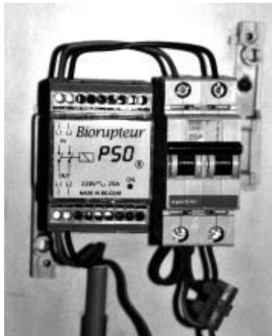
Il existe plusieurs modèles de biorelais sur le marché. Un circuit électrique bien pensé évite d'utiliser cette technique.
