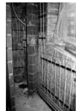
Une maison où le chauffage rayonne comme le soleil.
