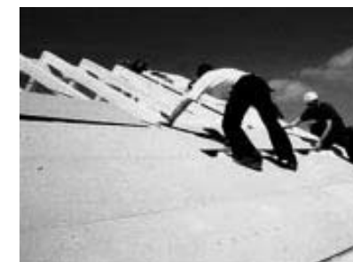
Les panneaux de sous-toiture protègent le gros œuvre de la pluie avant la finition de la toiture. Ils permettent au couvreur de marcher directement sur la toiture, ce qui facilite son travail.
